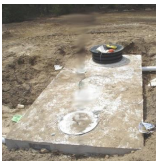
Slika 5. Izgled izgrađene septičke jame
